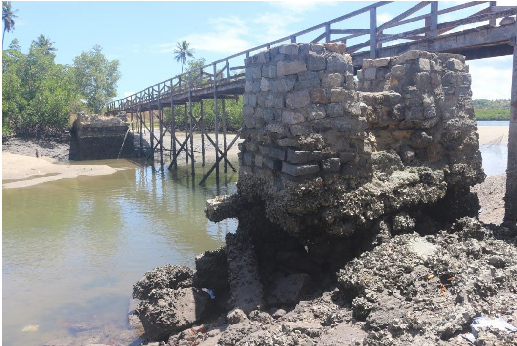
Figura 17: Remanescentes das duas cabeças da ponte histórica, ladeada pela ponte de madeira utilizada atualmente. Acervo dos autores.
