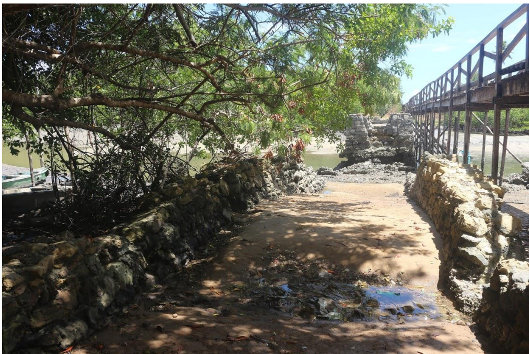
Figura 18: Restos construtivos de diferentes temporalidades podem ser observados no perfil da ponte. Acervo dos autores.
